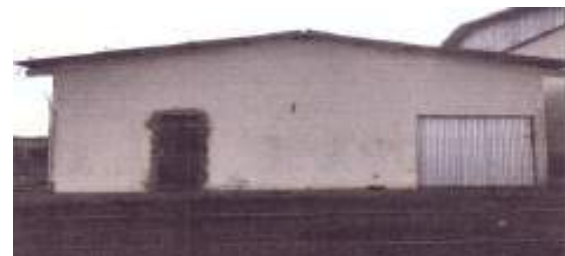
DEPÓSITO ALMOXARIFADO 100M 2
