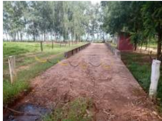
BALANÇA ALVENARIA 75M 2
